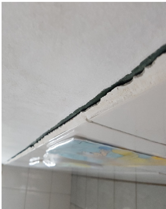
Descolamento da cerâmica da parede do banheiro masculino
